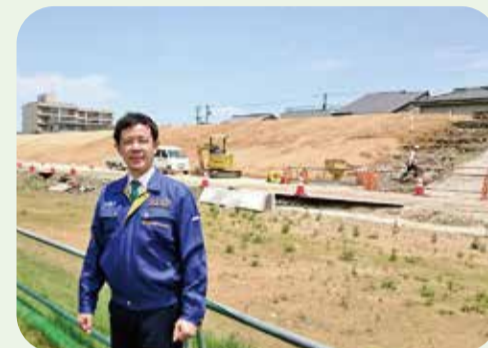
▲令和2年7月時点の神通川堤防の築堤工事現場の様子
